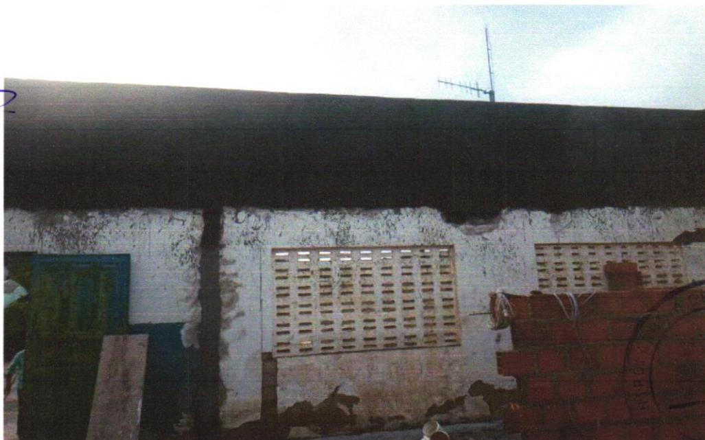
FOTO 12 – MASSA ÚNICA, PARA RECEBIMENTO DE PINTURA OU CERÂMICA, ARGAMASSA INDUSTRIALIZADA, PREPARO MECÂNICO, APLICADO COM EQUIPAMENTO DE MISTURA E PROJEÇÃO DE 1,5 M3/H EM FACES INTERNAS DE PAREDES, ESPESSURA DE 5MM, SEM EXECUÇÃO DE TALISCAS. AF_06/2014
