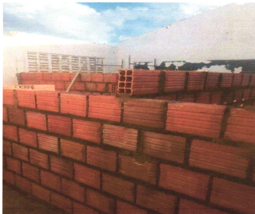
FOTO 06 – ALVENARIA DE VEDAÇÃO DE BLOCOS CERÂMICOS FURADOS NA HORIZONTAL DE 9X19X29 CM (ESPESSURA 9 CM) E ARGAMASSA DE ASSENTAMENTO COM PREPARO EM BETONEIRA. AF_12/2021
