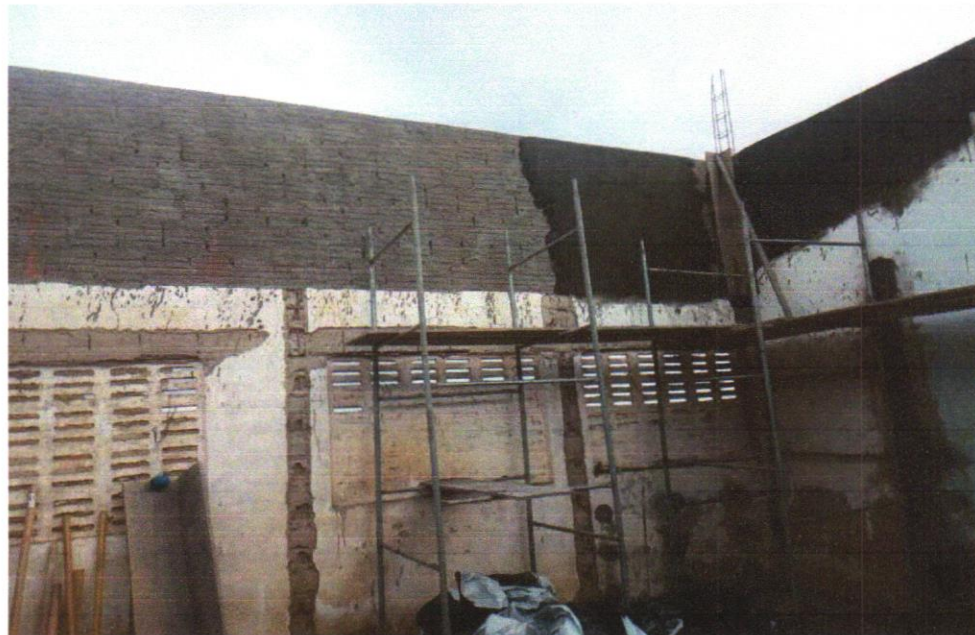
FOTO 11 – CHAPISCO APLICADO EM ALVENARIA (COM PRESENÇA DE VÃOS) E ESTRUTURAS DE CONCRETO DE FACHADA, COM EQUIPAMENTO DE PROJEÇÃO. ARGAMASSA TRAÇO 1:3 COM PREPARO EM BETONEIRA 400 L. AF_06/2014
