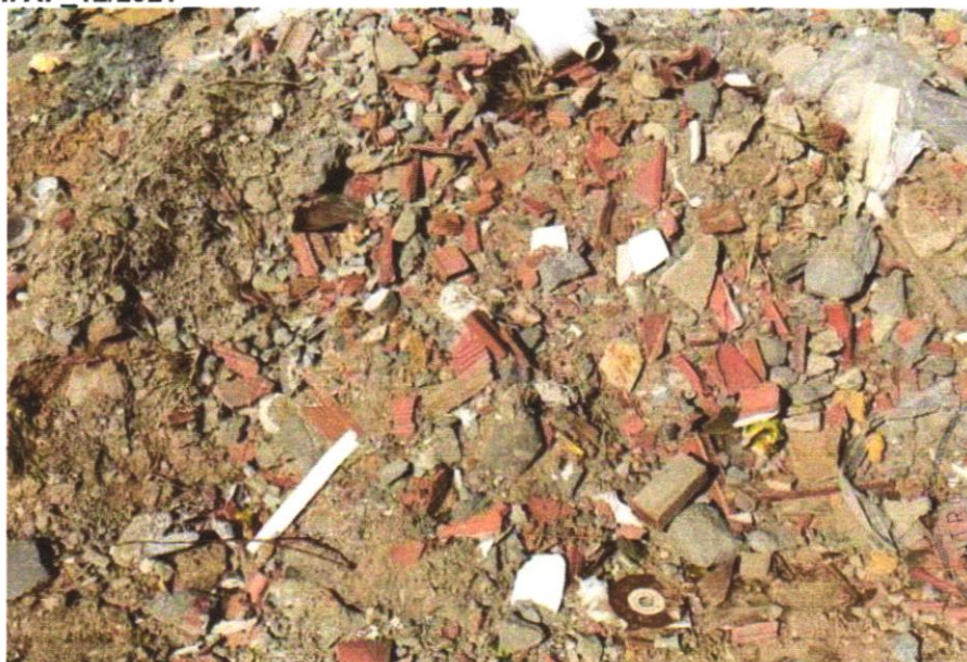
FOTO 08 – DEMOLIÇÃO DE ALVENARIA DE BLOCO FURADO
