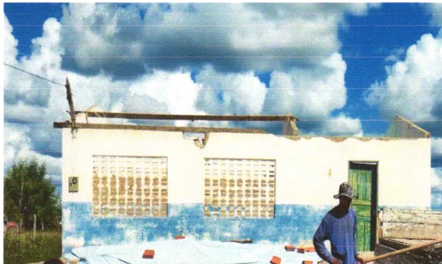
FOTO 01 – REMOÇÃO DE TELHAS, DE FIBROCIMENTO, METÁLICA E CERÂMICA, DE FORMA MANUAL, SEM REAPROVEITAMENTO. AF_12/2017
