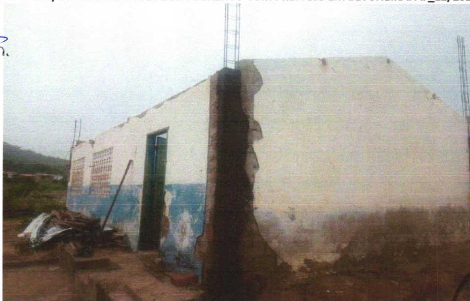
FOTO 10 – COMPOSIÇÃO REPRESENTATIVA) EXECUÇÃO DE ESTRUTURAS DE CONCRETO
