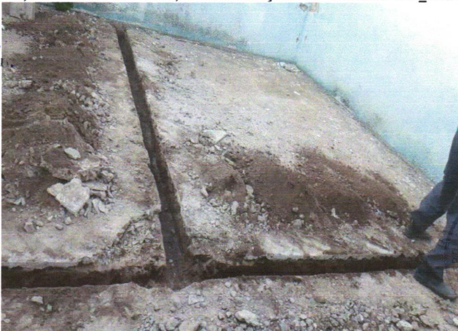
FOTO 14 - ESCAVAÇÃO MANUAL DE VALA PARA VIGA BALDRAME (INCLUINDO ESCAVAÇÃO PARA COLOCAÇÃO DE FÔRMAS). AF_06/2017
