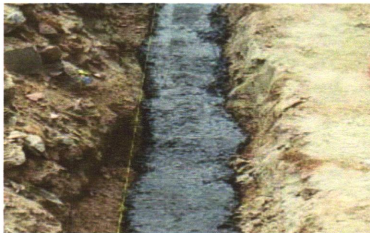
FOTO 05 – LASTRO DE CONCRETO MAGRO, APLICADO EM BLOCOS DE COROAMENTO OU SAPATAS, ESPESSURA DE 3 CM. AF_08/2017
