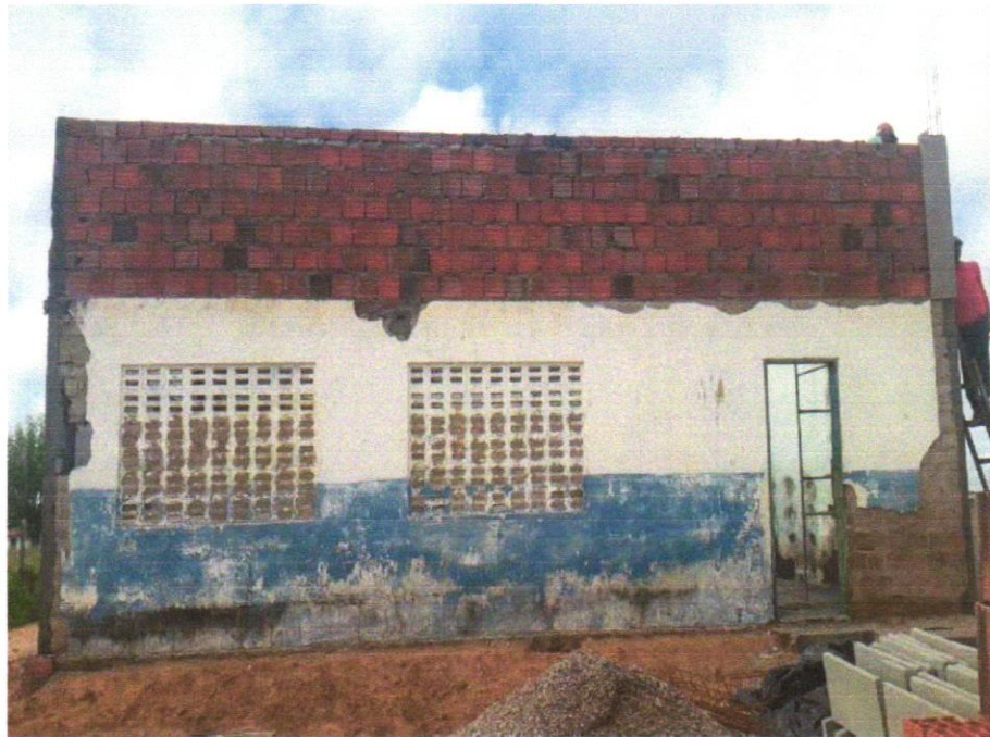
FOTO 03 - ALVENARIA DE VEDAÇÃO DE BLOCOS CERÂMICOS FURADOS NA HORIZONTAL DE 9X19X29 CM (ESPESSURA 9 CM) E ARGAMASSA DE ASSENTAMENTO COM PREPARO EM BETONEIRA. AF_12/2021
