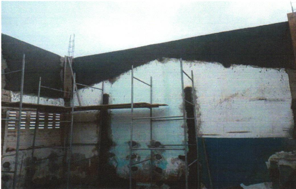
FOTO 13 – MASSA ÚNICA, PARA RECEBIMENTO DE PINTURA OU CERÂMICA, ARGAMASSA INDUSTRIALIZADA, PREPARO MECÂNICO, APLICADO COM EQUIPAMENTO DE MISTURA E PROJEÇÃO DE 1,5 M 3 /H EM FACES INTERNAS DE PAREDES, ESPESSURA DE 5MM, SEM EXECUÇÃO DE TALISCAS. AF_06/2014
